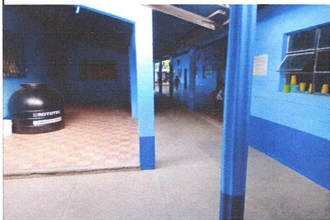
Foto1: Pintura aplicada a paredes exteriores de las aulas.
