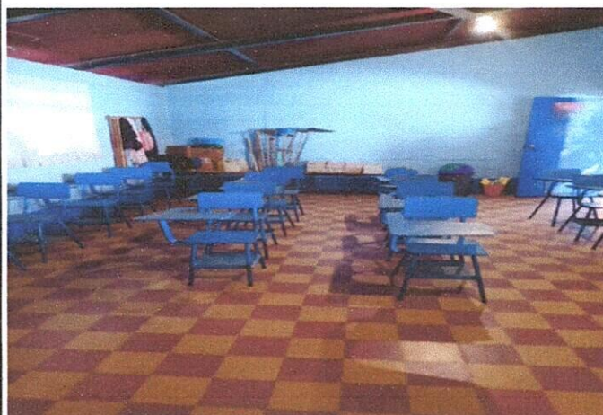
Foto 2: Pintura aplicada a paredes interiores de las aulas.
