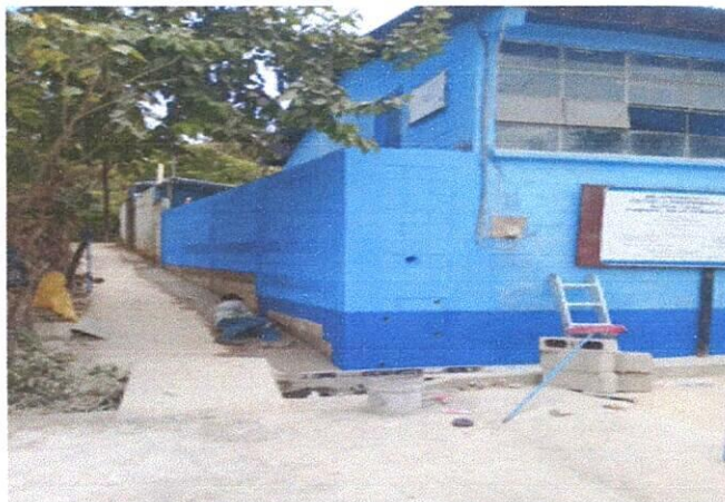
Foto 1: Finalización remozamiento muro perimetral.
